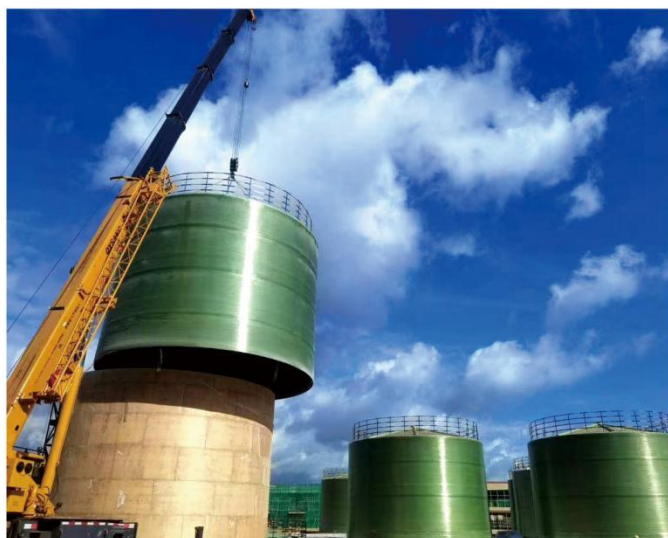
广东肇庆星湖股份施工现场
