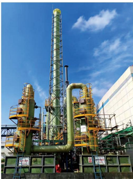
玻璃钢烟囱 Glass steel chimney
