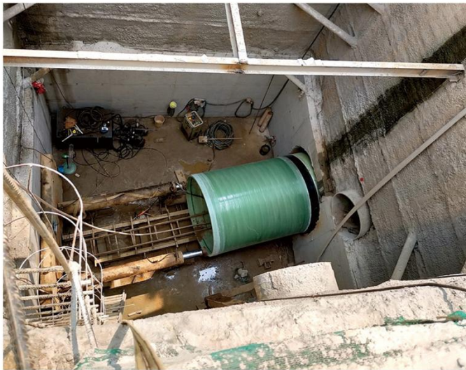
玻璃钢顶管 FRP pipe jacking
