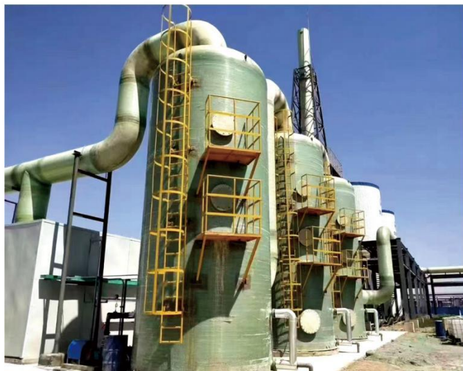
北京中芯电子施工现场
