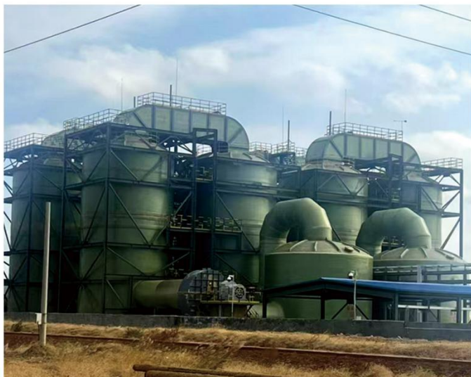
内蒙三联化工施工现场
