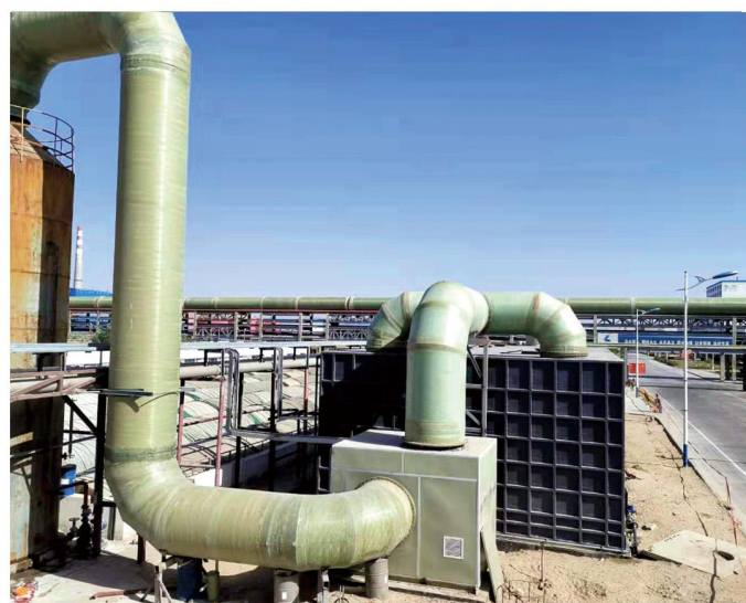
福建紫金矿施工现场
