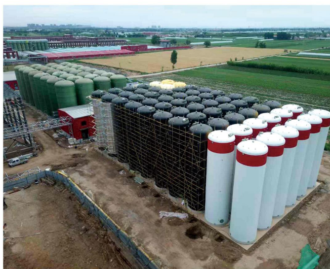
珠江桥食品酿造厂施工现场
