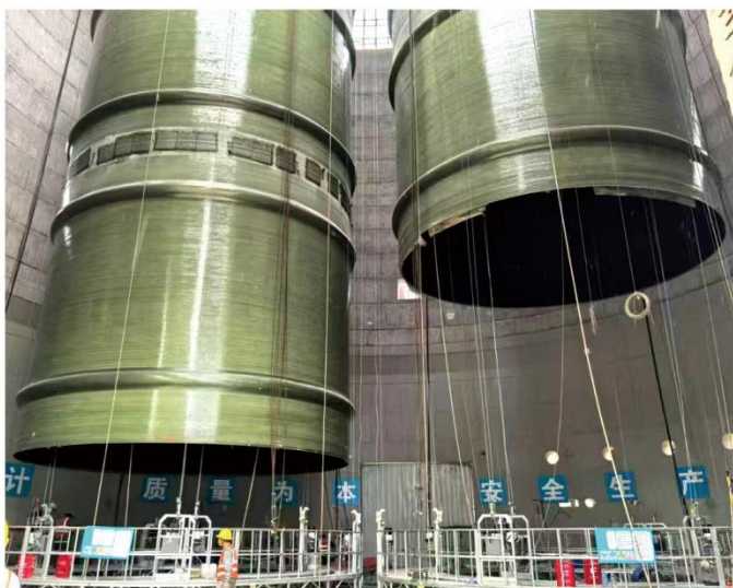
天津电厂施工现场
