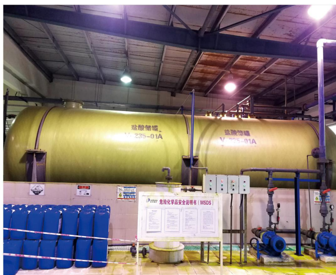
新加坡胜科水务（中国）潞安煤化工施工现场
